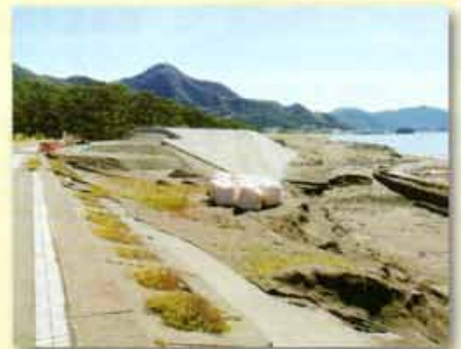
沼津市牛臥海岸の津波防潮堤工事
